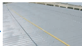
トップコート塗布後完成
