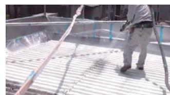
断熱補強層 施工 (SGフォーム吹付け)
